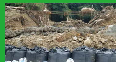
▲8月14日 県北地域豪雨災害現地調査(村上市)
