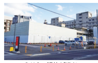
3/10 解体が進む県立加茂病院旧病棟
